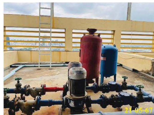
ถังเก็บน้ำดาดฟ้า พร้อมเครื่องปั๊มน้ำ
