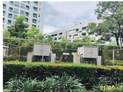
หม้อแปลงไฟฟ้า ขนาด 1,250 KVA อาคาร B
